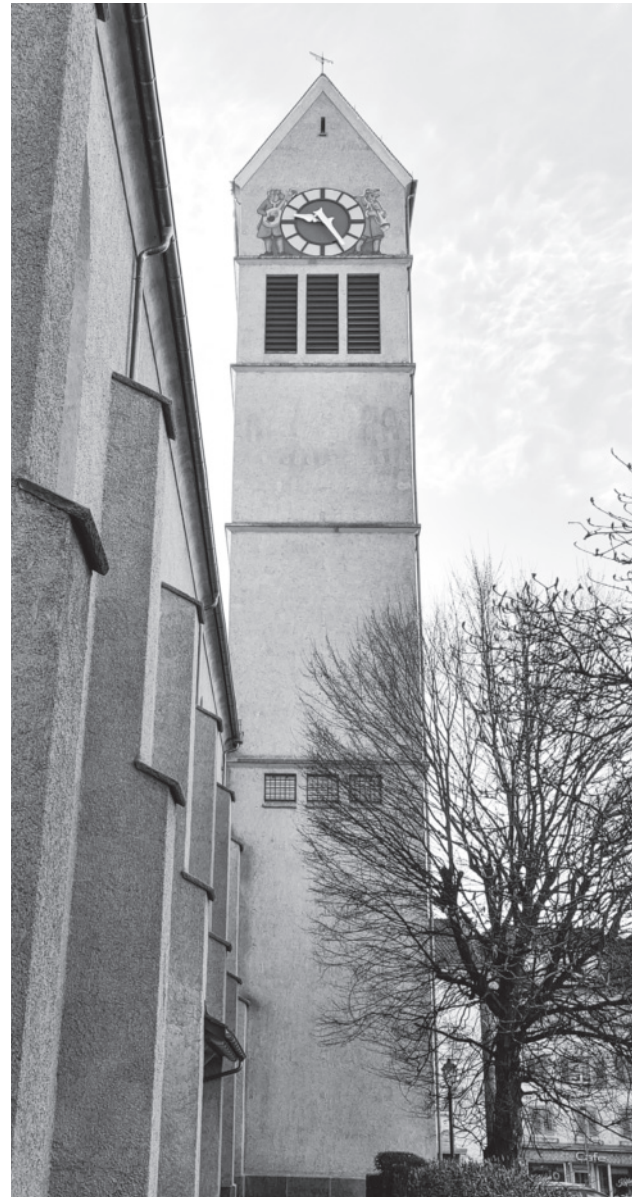
Turm nach Sanierung
