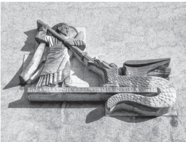
Hl. Michael vor Sanierung
