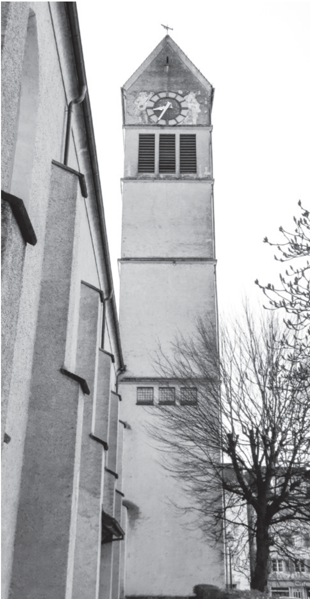
Turm vor Sanierung
