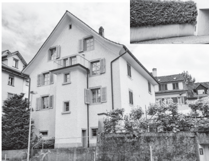
Ansicht Oberer Stadtgraben
